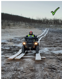
Figur 10: Eksempel på etablert terrengforsterkning over bløte partier.
