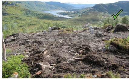
Figur 18: Godt tilbakeført fundament. Overgang mellom fundament og omliggende terreng er ivaretatt på en naturlig måte. Overflaten er rufsete og godt tilrettelagt for naturlig revegetering.
