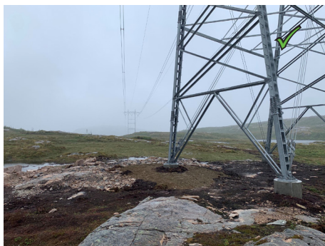
Figur 22: Her er sprengsteinsblokk fjernet fra overflaten.
