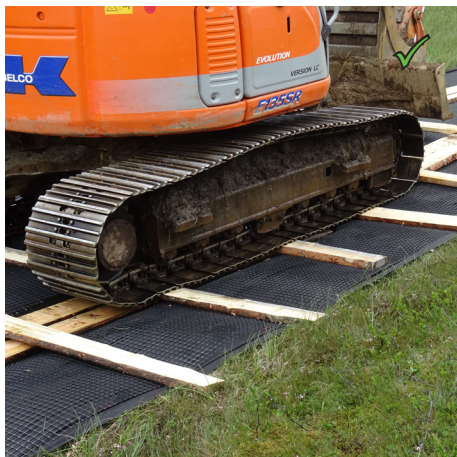
Figur 13: Terrengforsterkning for transport av gravemaskin over bløtt underlag.
