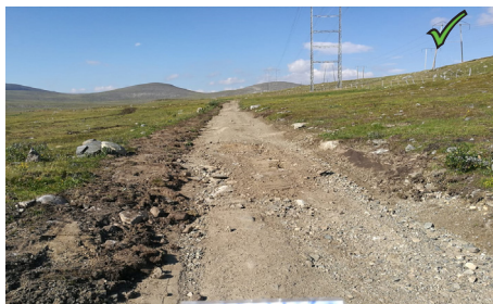
Figur 35: Godt tilrettelagt kjørespor der vegetasjonsmasser er lagt til side for istandsettingem
