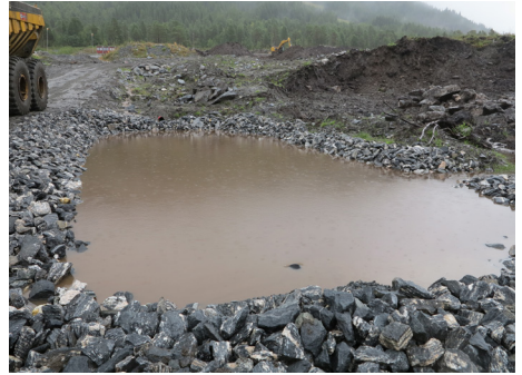
Figur 43: Prosjektert sedimentasjonsbasseng. Utlopet er neddykket for at eventuelle oljerester skal kunne samles opp på overflaten i bassenget.
