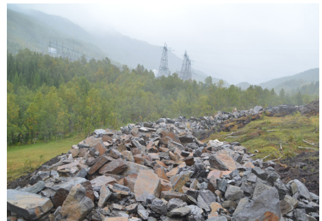
Figur 46: Motfylling for å forhindre at masser renner utenfor deponiområdet.
