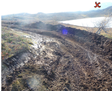
Figur 9: Bote og bæresvake partier skal ikke graves til side for å lette transporten. Det oppstår da fare for uttørring av tilstøtende arealer.
