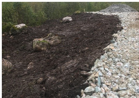
Figur 38: Istandsatt sidetereng i tråd med veilederen fra landbruksdirektoratet, "Skogsbilvegbygging med miljøsensyn".
