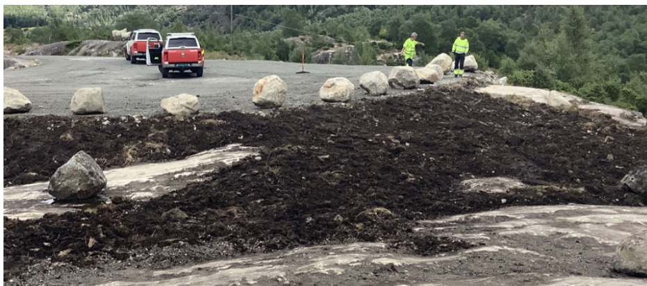
Figur 39: Eksempel på ferdigstillt hjelpeanlegg, istandsatt etter Landbruksdirektoratets veileder.
