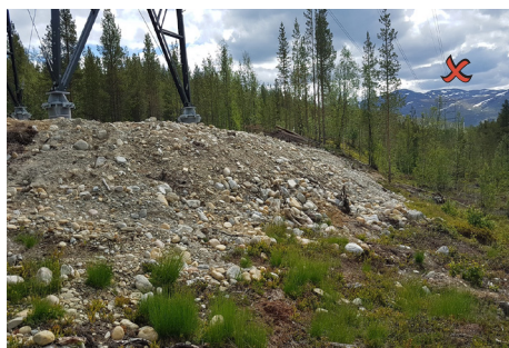
Figur 26: Vegetasjonsmasser er ikke lagt ut som topplag. Selv om det er et område med skrint jordsmonn, må det som er av vegetasjonsmasser tas vare på for istandsetting. Utplassering av vegetasjonstuer ville ha brutt overflaten, og lagt grobunn for raskere naturlig revegetering.
