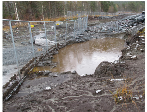
Figur 44: Enkelt sedimentasjonsbasseng for oppsamling av sand og gruspartikler. Viktig at de blir tomt regelmessig, for å opprettholde funksjonen.
