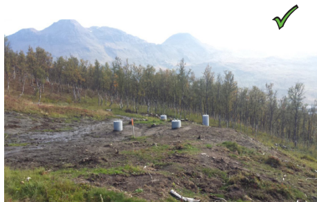
Figur 25: Toppmasser er lagt tilbake slik at naturlig revegetering kan starte. Massene er i tillegg lagt ut slik at overgang mellom omliggende terreng og punktet, blir naturtro.
