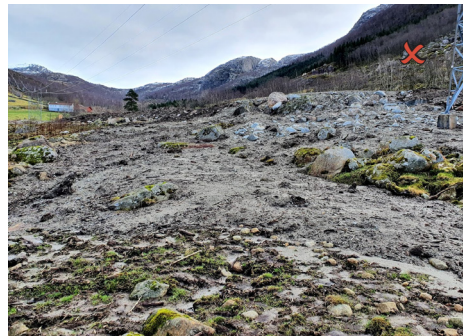
Figur 15: Baseplassen er etablert uten tilstrekkelig kontroll med avrenning. Bløte masser har glidd ut og mengder med finstoff har blitt fraktet over terreng og ned til et vassdrag. Det har ikke vært etablert tilstrekkelig med avskjærende grøfter for å håndtere intensive nedbørsperioder.
