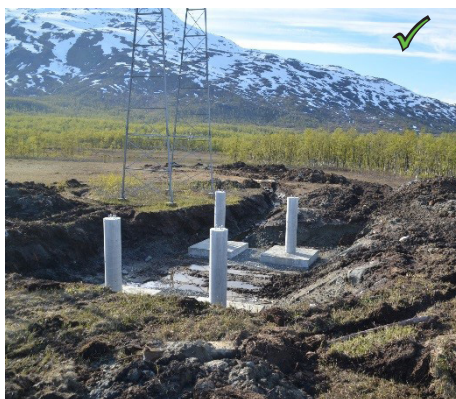
Figur 17: Godt eksempel på at vegetasjonslaget er tatt vare på, for bruk til istandsetting.
