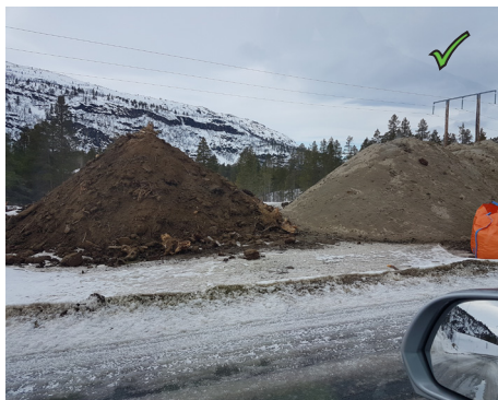
Figur 16: Riktig lagring av vegetasjonsmasser og mineraljord. Massene er lagret i separate ranker/hauger slik at istandsetting kan gjennomføres med vegetasjonsmasser øverst.
