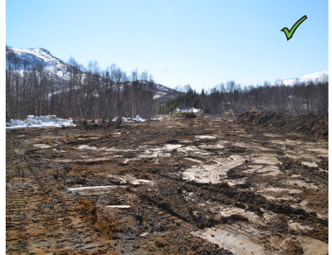
Figur 14: Topplaget er skavet av og lagret i ranke til høyre i bilde. Massene skal benyttes ved istandsetting.
