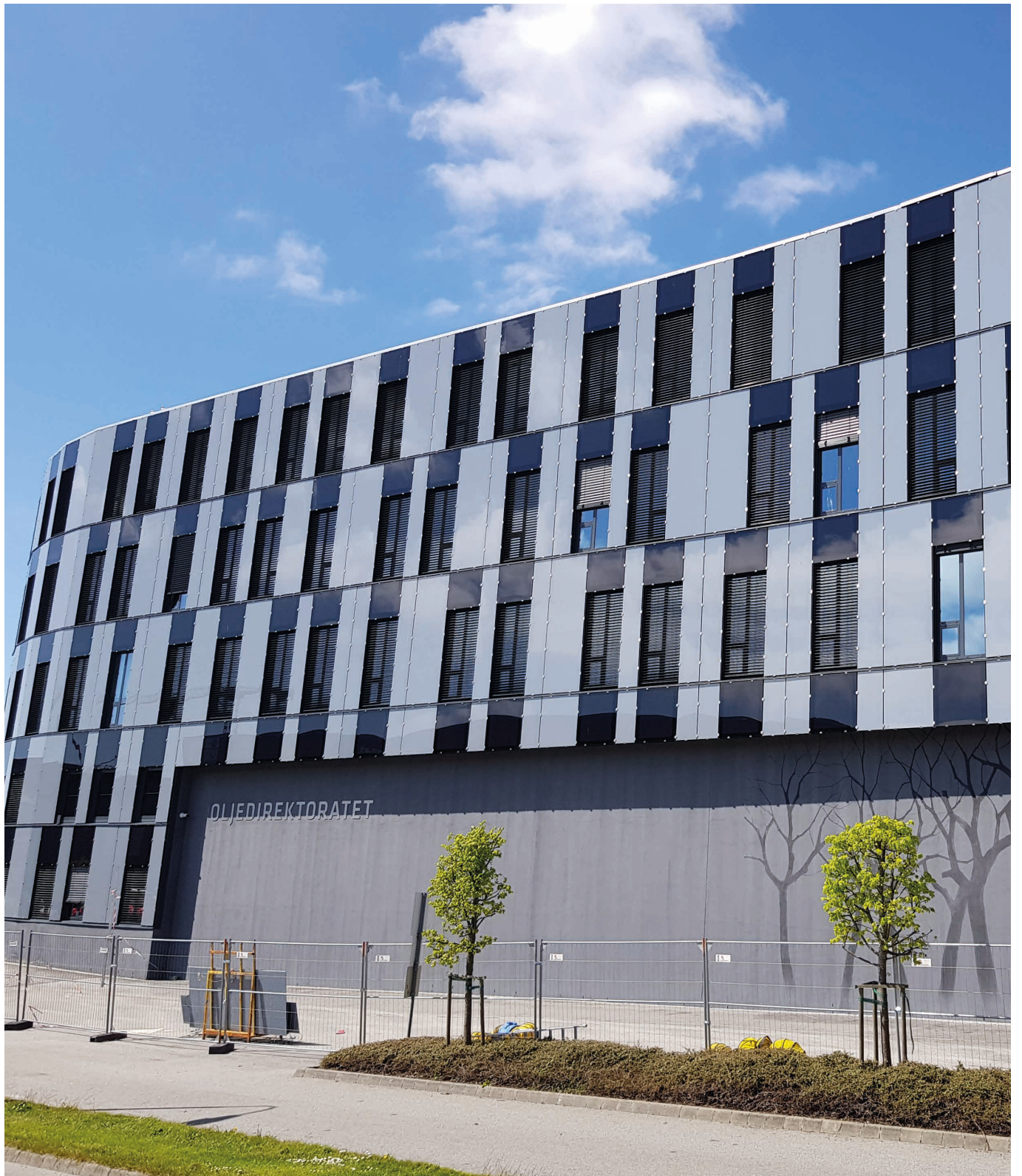
Bygningsintegrert solcelleanlegg i Oljedirektoratets fasade - Bilde: FUSen
