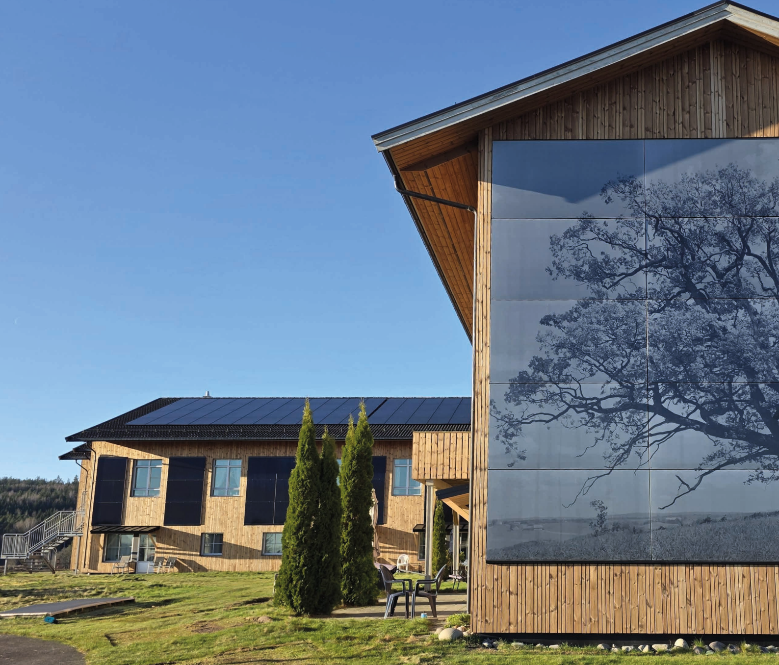
Bygningsintegret solcelleanlegg på Gjerdrum Helsehus – Bilde: FUSen
