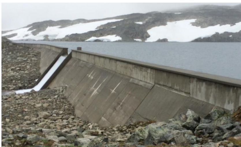
Figur 2 Betong gravitasjonsdam (photo: T.Konow).
