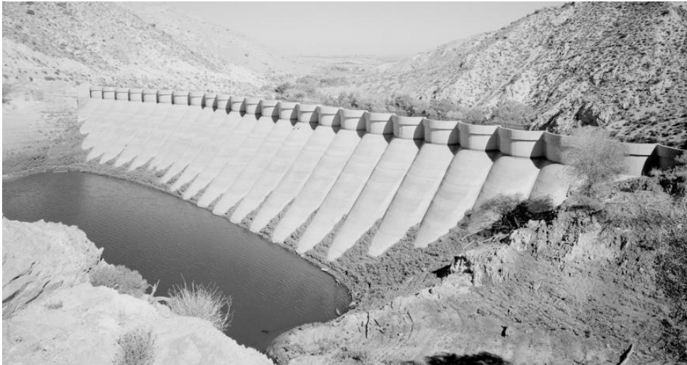
Figur 6 Oppstrøms side av en flerbuedam (Photo: National Park Service, US)
