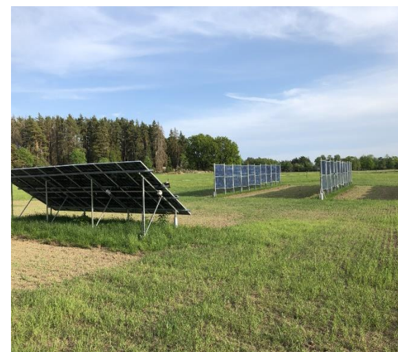
figur 41 Åpent agrivoltaisk system med vertikale, tosidige solpaneler i Kärrbo Prästgård, Sverige. Bilde: Mälardalens Universitet
