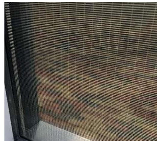
Figur 46: Halvgjennomsiktige solcellemoduler med tynnfilmceller og mellomrom mellom cellene. Tynnfilmceller er mindre enn silisiumceller. Bilde: @solcellsarkitektur, Malin Unger
