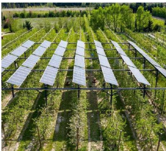
figur 40 Opphøyd agrivoltaisk system med énaksede solfølgere, av Sun'Agri. Bilde: Sun'Agri
