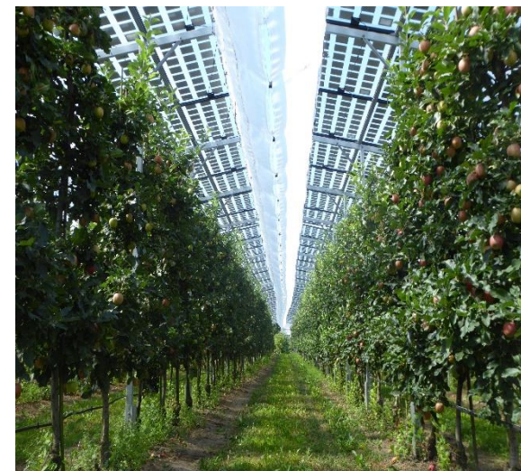
figur 39 Opphøyd agrivoltaisk system med fast hellingsvinkel. Bilde: MHM55 (CC BY-SA 4.0 licens)
