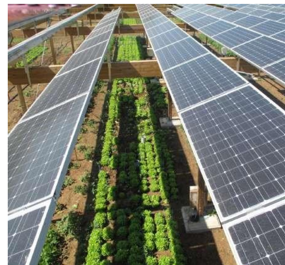
Figur 31 Dyrking kan foregå enten under solcellepanelene (t.v.) eller mellom dem (t.h.), avhengig av panelenes utforming.
