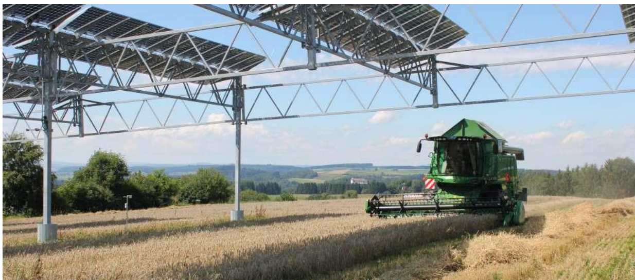
Figur 31 Dyrking kan foregå enten under solcellepanelene (t.v.) eller mellom dem (t.h.), avhengig av panelenes utforming.
