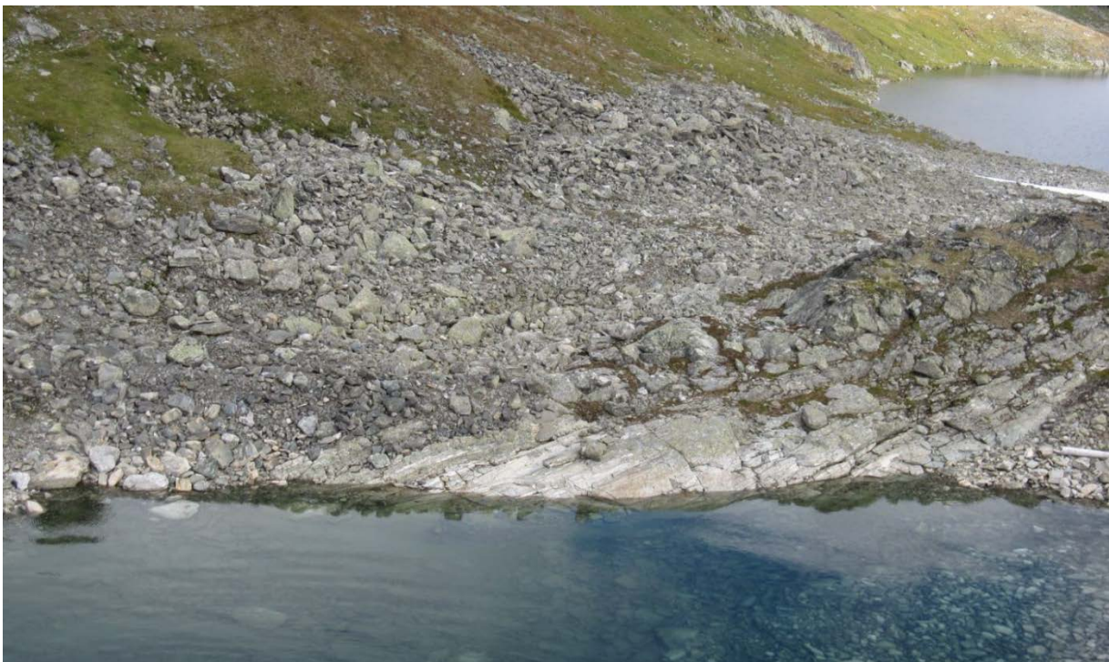
Foto A5. Sperredam Ølju (Foto: E-CO)
