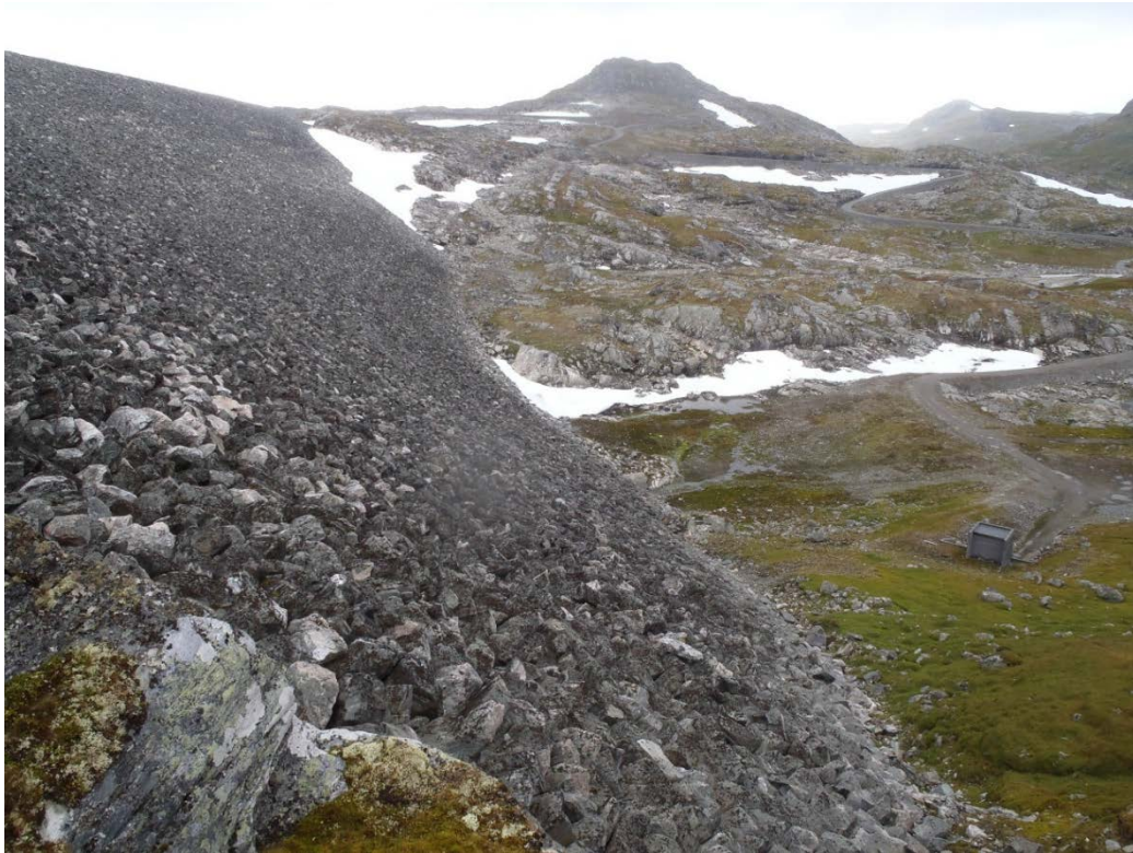
Foto A4. Nedstrøms skråning ved Hoveddam (Foto: E-CO).
