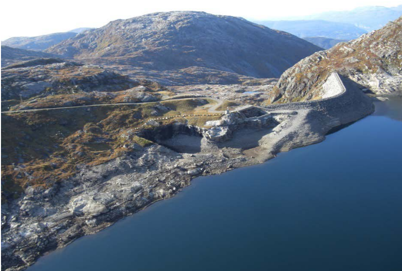
Foto A3, A4, A5 Dam Dravladalen før rehabilitering (2010) (Foto Statkraft)
