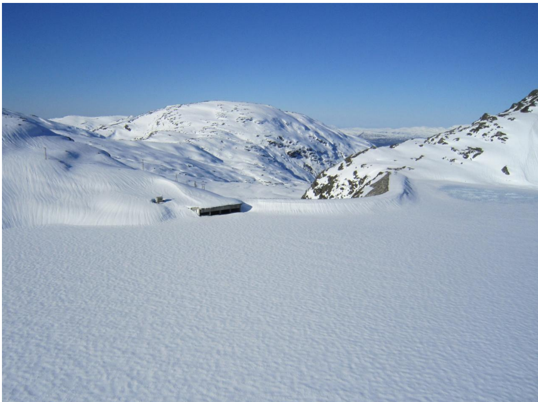
Foto A17, A18. Dam Dravladalens overløp etter rehabilitering (Foto Statkraft)
