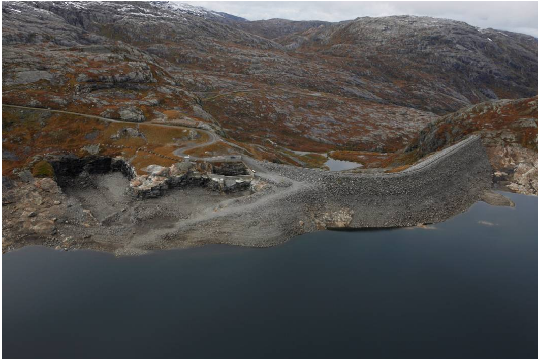
Foto A1. Dam Dravladalen før rehabilitering (2010) (Foto: Statkraft)
