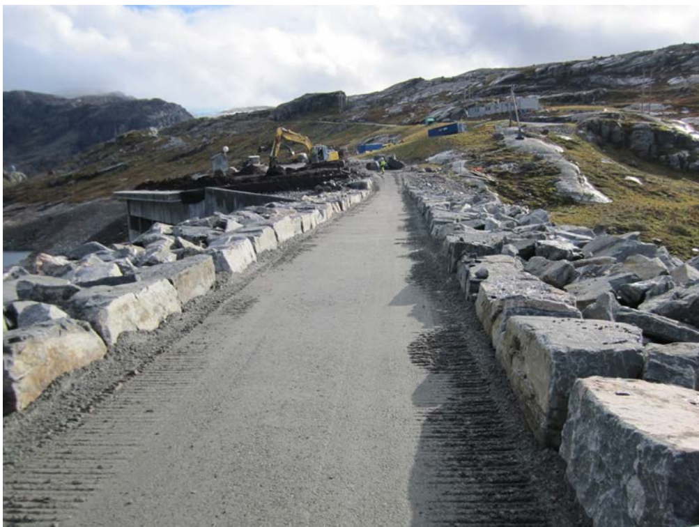
Foto A15, A16. Damkrone, Dam Dravladalen, etter rehabilitering (Foto: Statkraft)
