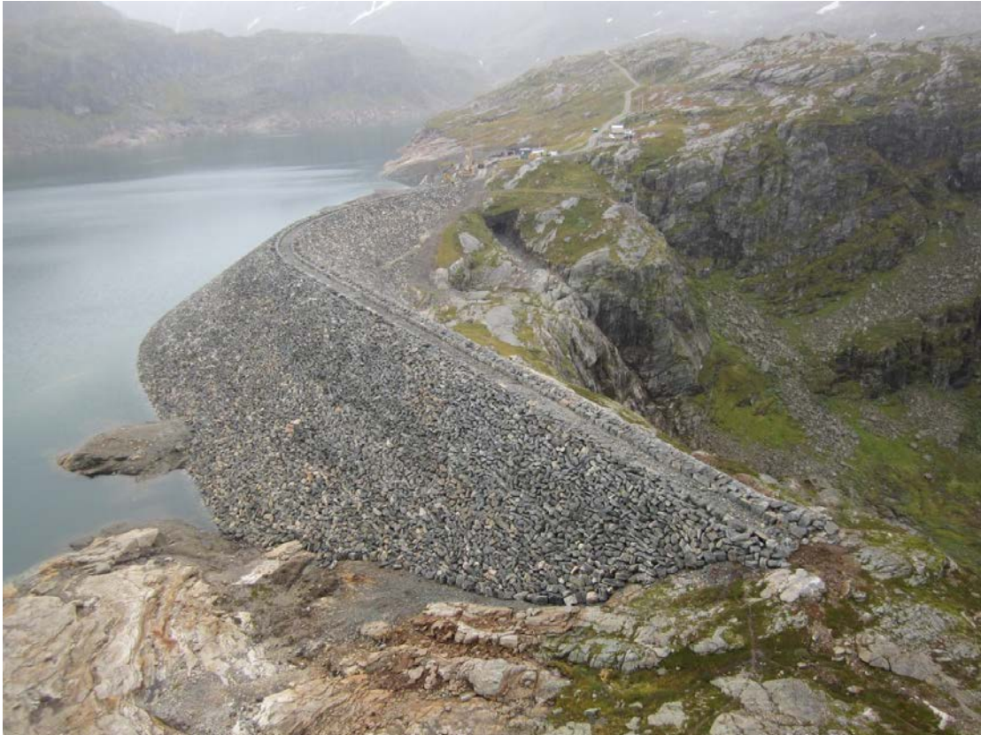
Foto A11, A12. Dam Dravladalen etter rehabilitering (Foto: Statkraft)
