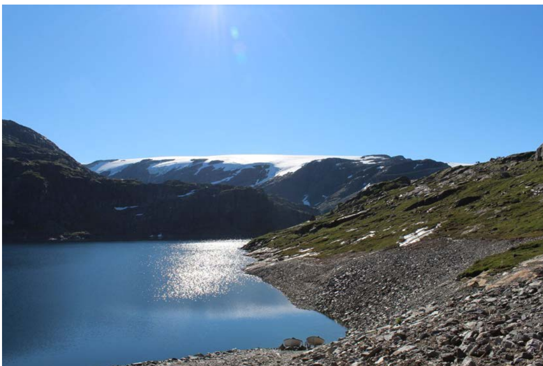
Foto A13, A14. Dam Dravladalen etter rehabilitering (Foto: Statkraft)
