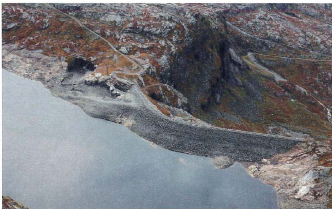
Foto A2. Oversiktsbilde av Dam Dravladalen før rehabilitering (2010) (Foto: Statkraft)
