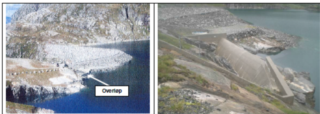
Figur A2.4 Dam Dravladalen og overløp (CM Consulting 2008a) (venstre: Dravladalsvatn fyllingsdam med overløp; høyre: Dravladalsvatn overløp)
