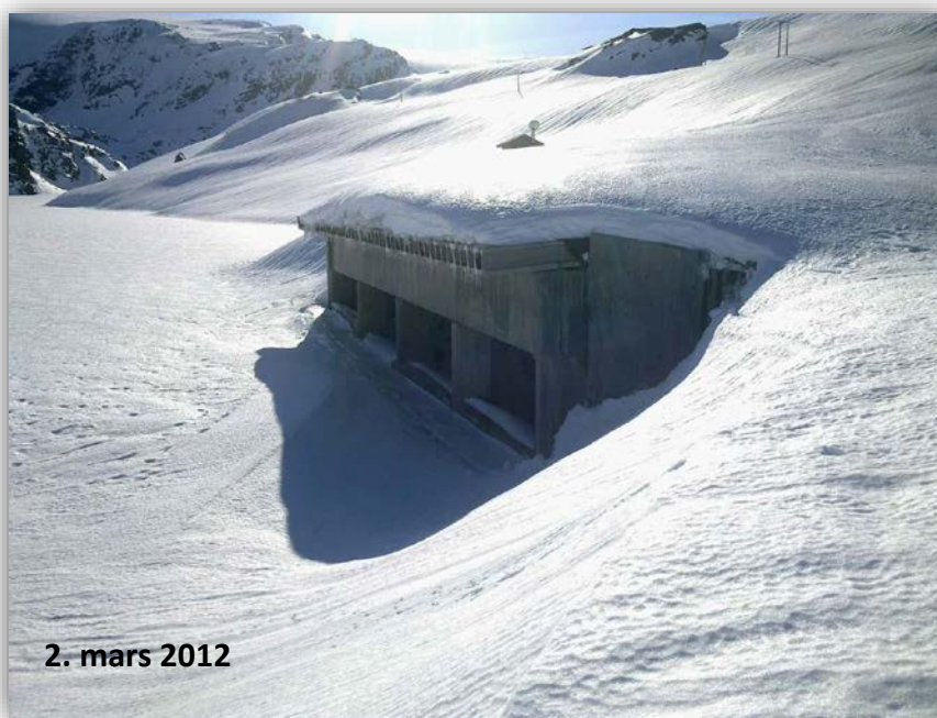
Foto A19, A20. Flomløp Dam Dravladalen, før og etter rehabilitering (2010-2012) (Foto: Statkraft)
