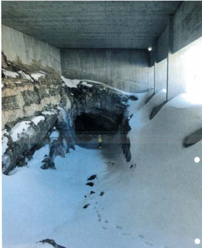
Foto A21. Flømløpstunnel, Dravladalen etter rehabilitering (Foto: Statkraft)
