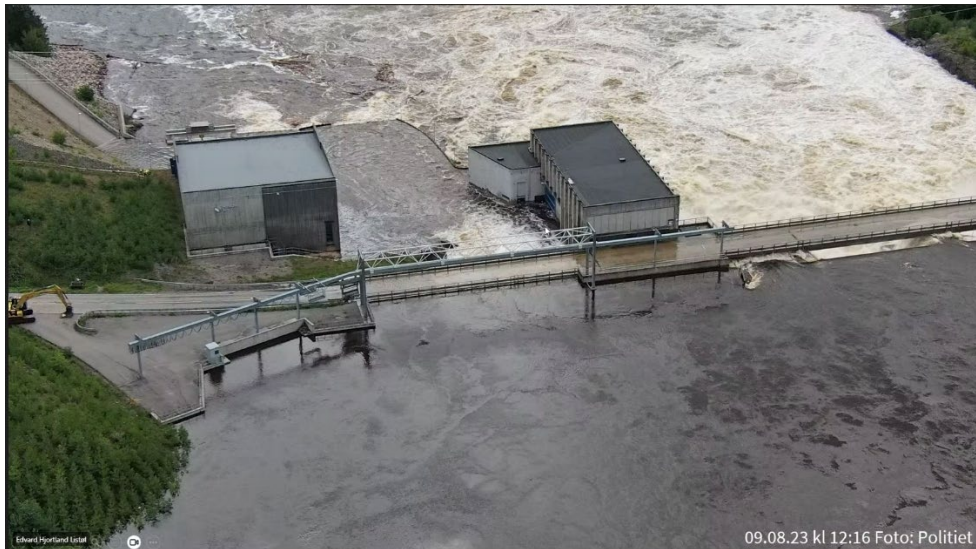
Bilde 11 Kraftverk og lukedam kl. 12:16 (Foto Politiet / Kilde NVE)
