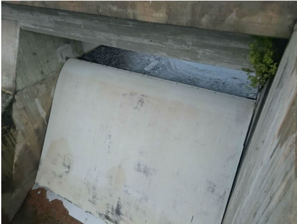
Bilde 7 Tømmerluke (Foto Sweco)
