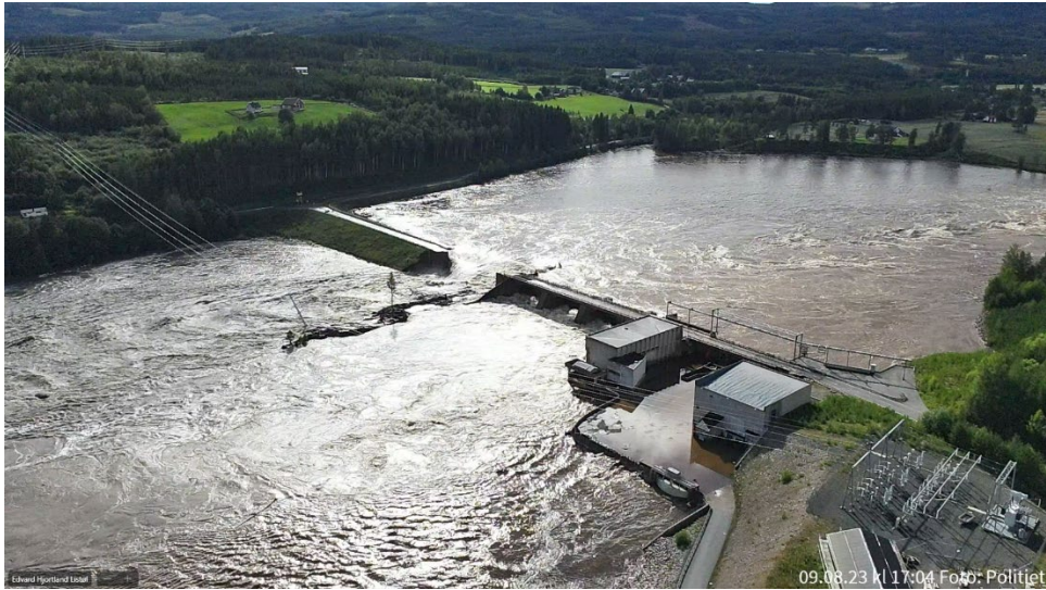
Bilde 13 Etter brudd på fyllingsdam kl. 17:04 (Foto Politiet / Kilde NVE)
