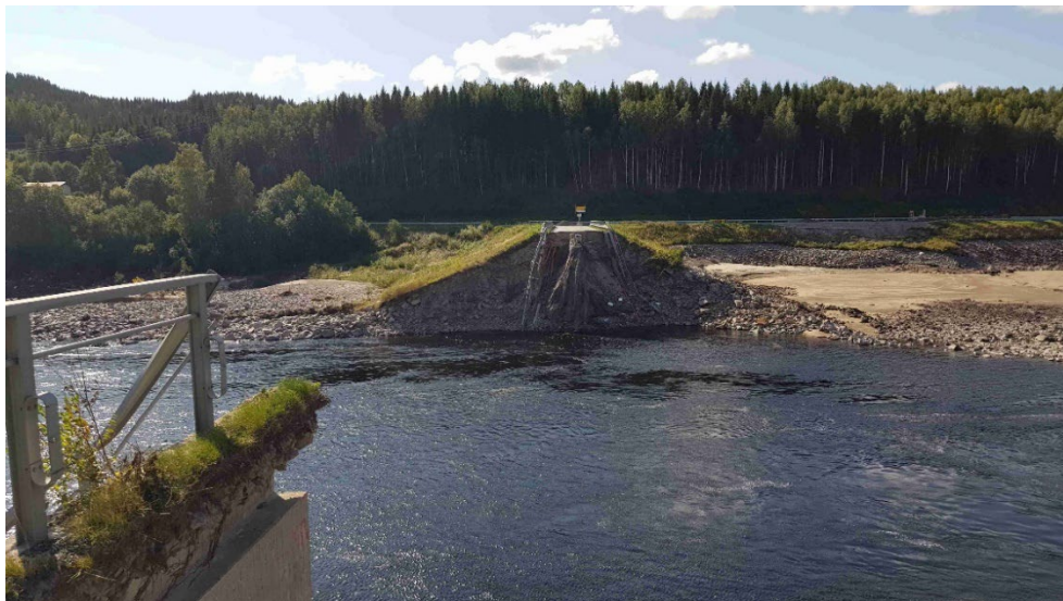
Bilde 14 Gjenstående rester av fyllingsdam etter dambrudd (foto DNV)
