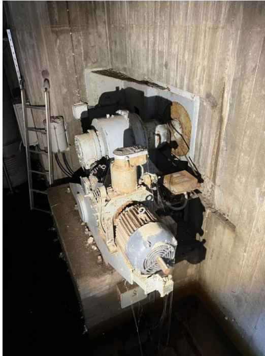
Lukespill, med motorer som har vært dykket.
