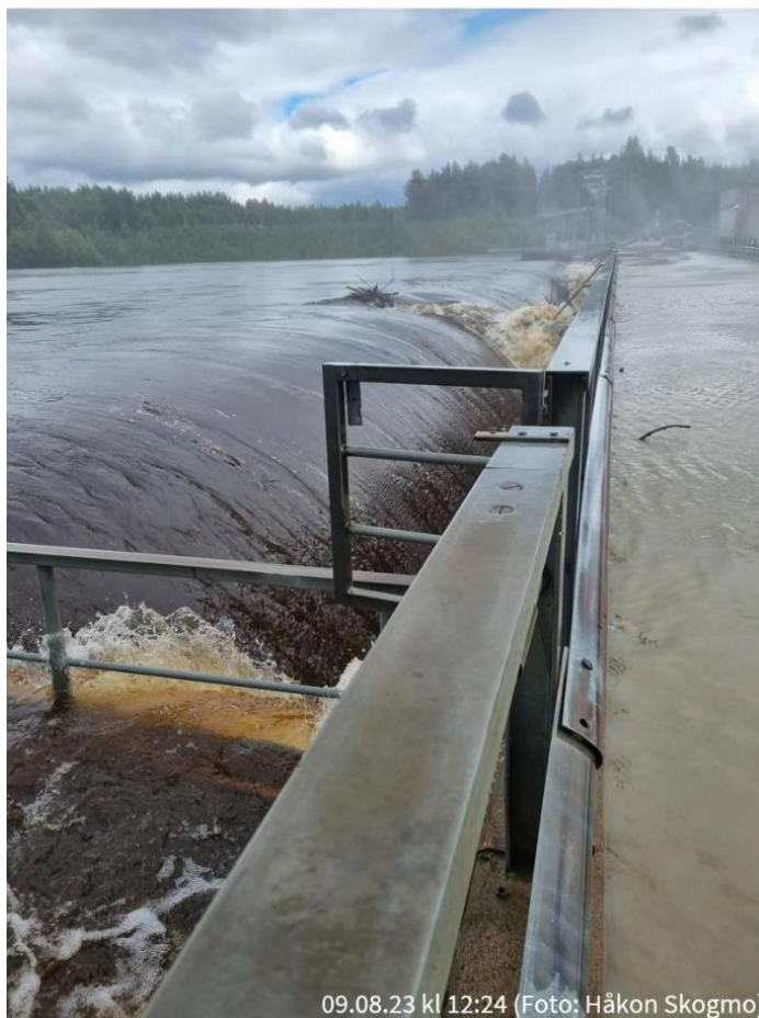
Her er vannstanden på høyde med vegbanen/damkrona på ca. kt. 166,5 moh.
