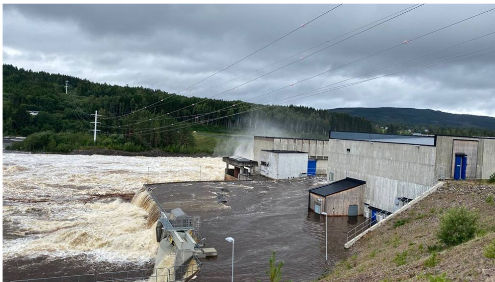
Bilde 9 Braskereidfoss kraftverk, formiddag 9. august 2023 (Kilde HEV)
