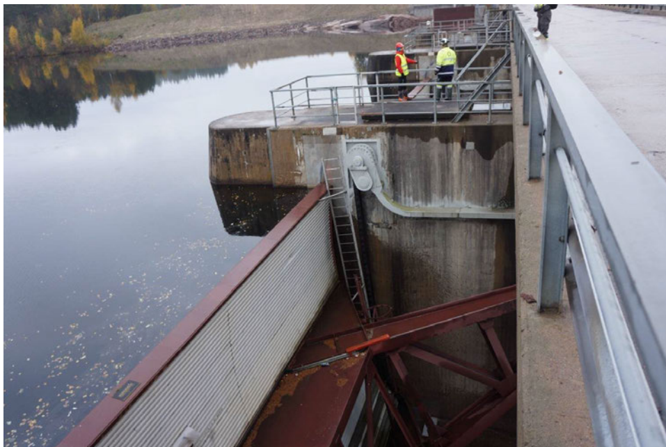
Bilde 6 Flomluke, pilar og lukehus (Foto Sweco)
