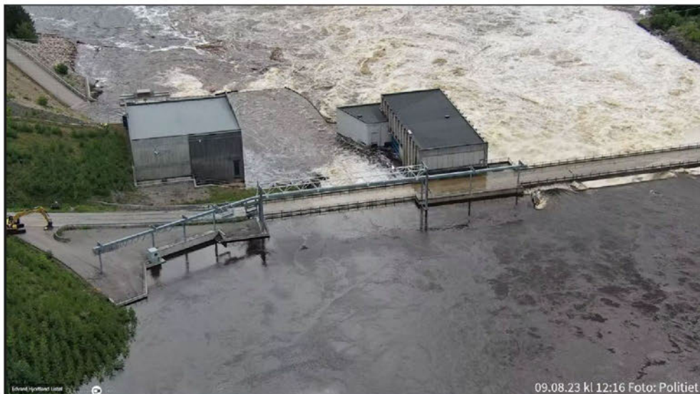
Bilde 1 Braskereidfoss kraftverk, 9. august 2023, kl. 12.16. Vannet strømmer over flomlukene og lamelldammen og inn i de to kraftstasjonene (Foto Politiet / Kilde NVE).
