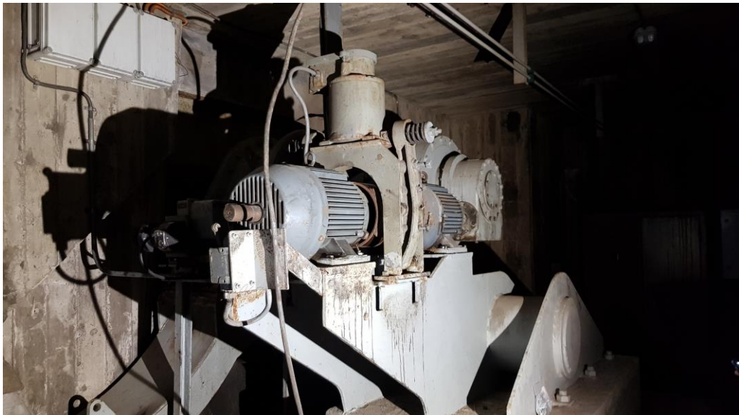
Kjedespill – flomluker. Foto DNV
