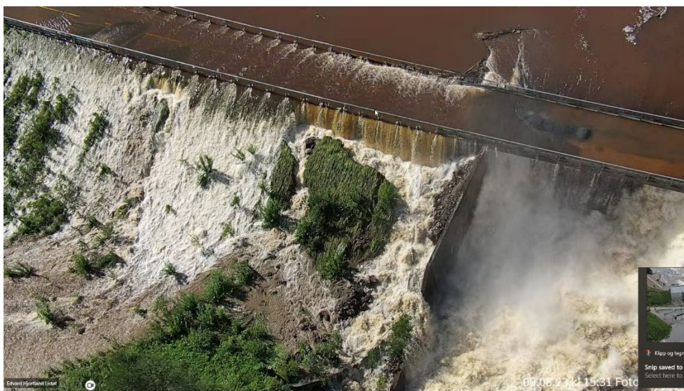
Bilde 12 Overtopping av veibro, fyllingsdam og lukedam kl. 15:31 (Foto Politiet / Kilde NVE)
