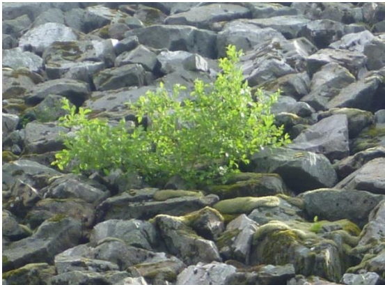
Figur 17 Vegetasjon i plastringen. Staffivatn sperredam.
