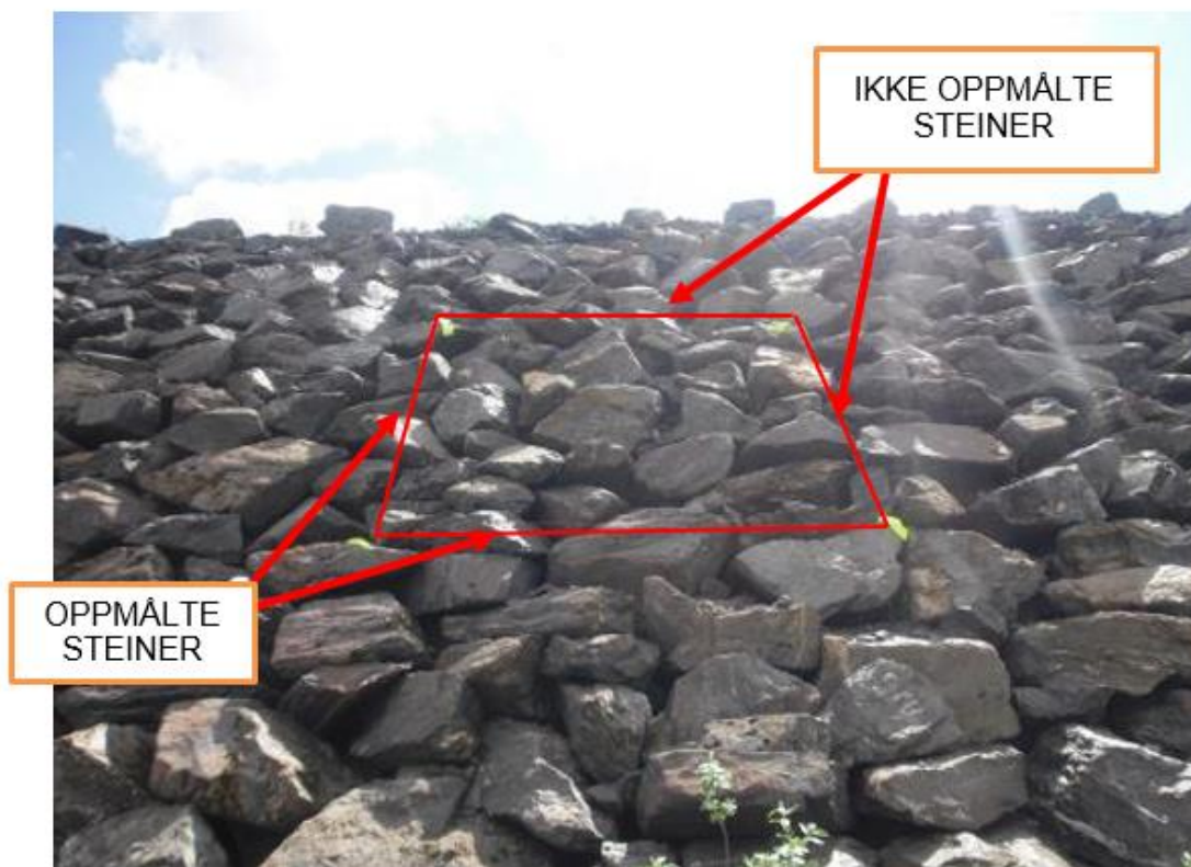
Figur 5 Bestemmelse av plastringstetthet i et 5x5 meter område.
