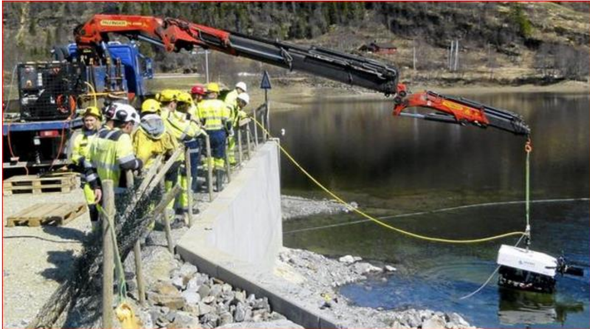
Figur 6-3 Demonstrasjon av ny ROV som kan kjøres flere kilometer inn i vanntunneler for å inspisere vannveien med luker og porter (foto: BKK 2017).
