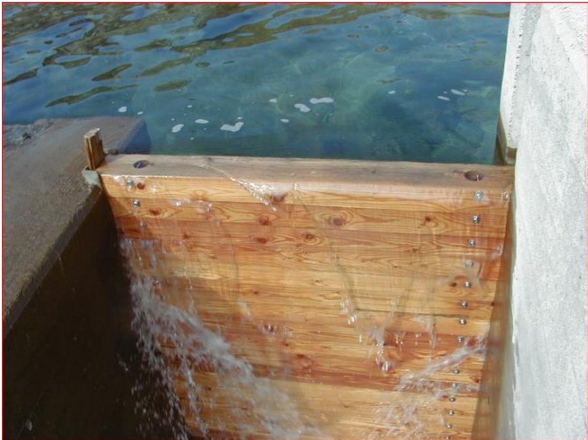
Figur 5-2 Bjelkestengsel i dammen ved Øvre Dukavatnet som benyttes for å vintersenke magasinet 1,7 meter under HRV i perioden 1.desember – 1.juni. Her står bjelkestengselet i «sommerstilling».
