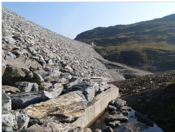
Figur 2-9 Etter rehabilitering i 2014 ble lekkasjemålepunktene bygget inn i damfoten. Bildet viser fangdammen i den vestlige delen av dammen.
