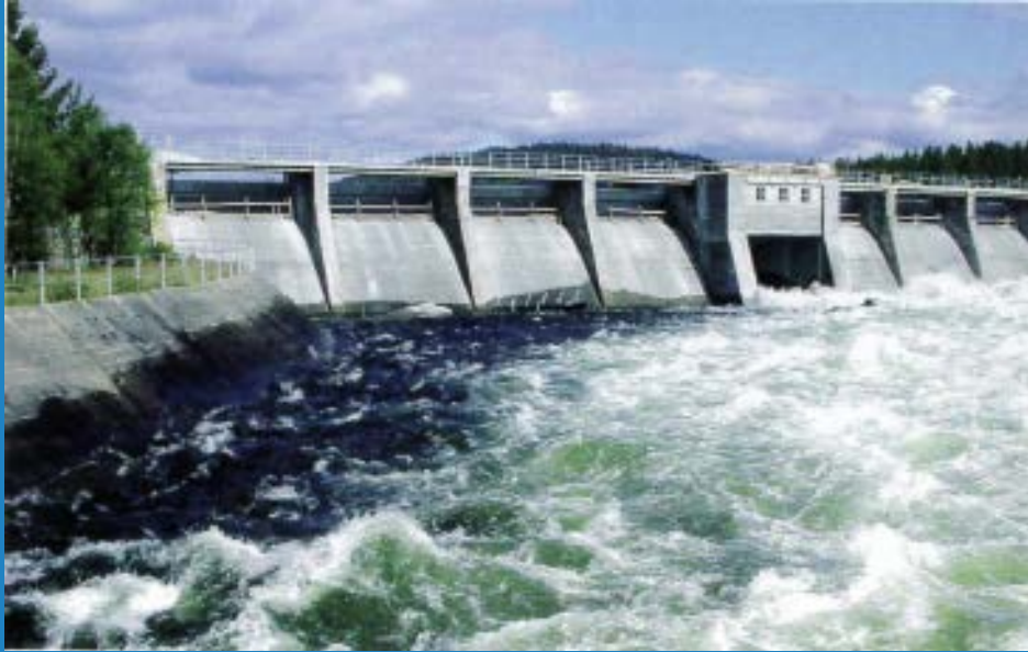
Pålsbu concrete dam (photo: Statkraft Energi AS)
