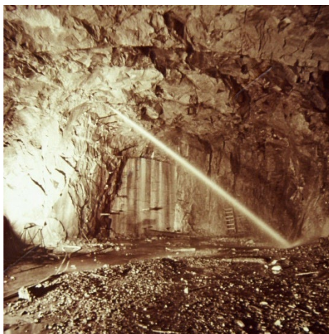
Figur 42 T.v.: Konsentrert vannstrøm fra sprekke med rør-/kanaldannelse i taket/vederlaget av dyp tunnel ved Kvilldal kraftverk (fra NTNU-lysbildearkiv) T.h.: Vannlekkasje fra svært gjennomsettende sprekke langs bergskjæring.
