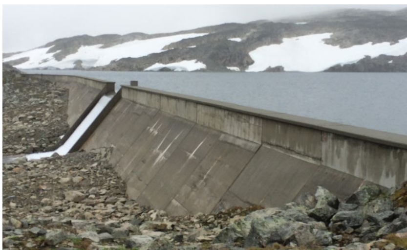
Figur 2 Betong gravitasjonsdam (photo: T.Konow).
