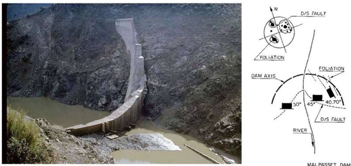
Figur 43 Brudd i venstre vederlag av Malpassetdammen som følge av en ugunstig orientert forkastning med fall 45–50° oppstrøms og foliasjonssprekker med fall 40° mot vest (plottet i stereografisk projeksjon, øvre halvkule). Venstre bilde fra (Duffault, 2012), skissen til høyre fra (Goodman, 1993).
