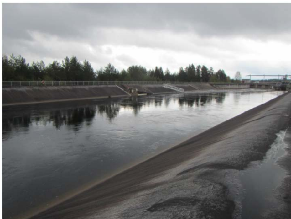
Figur 3. Bilde av inntakskanalen, sett medstrøms (Norconsult, 2016b)
